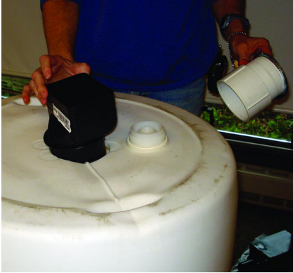
Desviador del bajante de aguas pluviales y adaptador del rebosadero (en la parte lateral)
