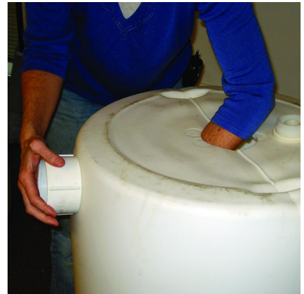
Ensamblaje del rebosadero
