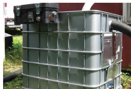
Cisterna pequeña externa con bomba solar
