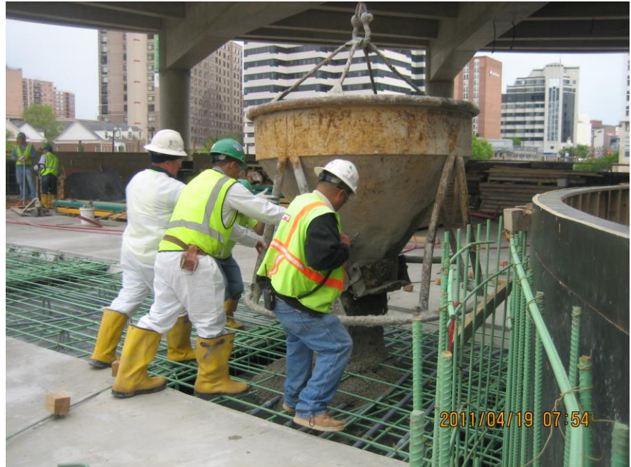
Image 6: West Level 330 Pour Strip Concrete Pour – April 19, 2011
